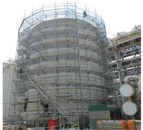
桶槽型外側包覆施工架
