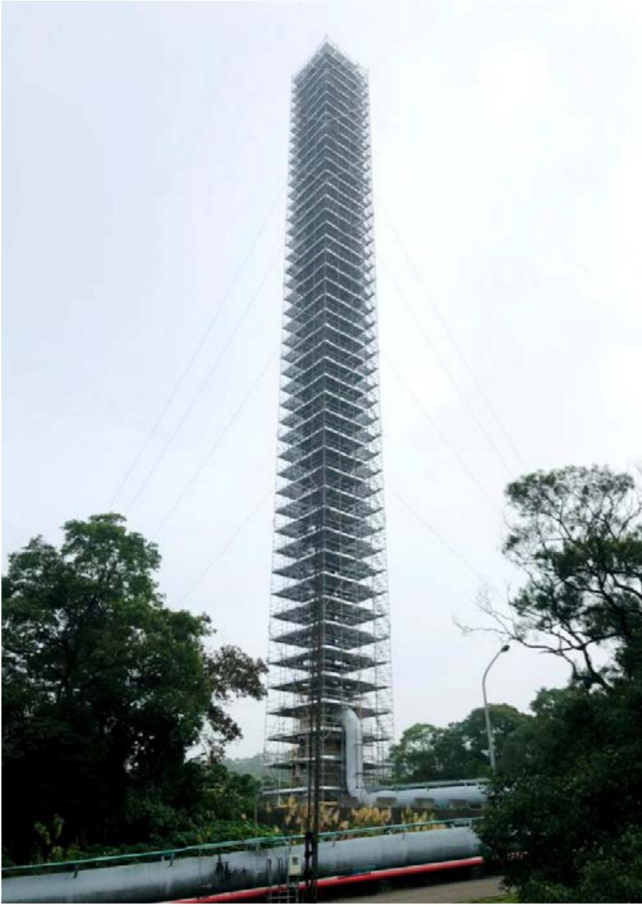
100m燃燒塔歲修用施工架
