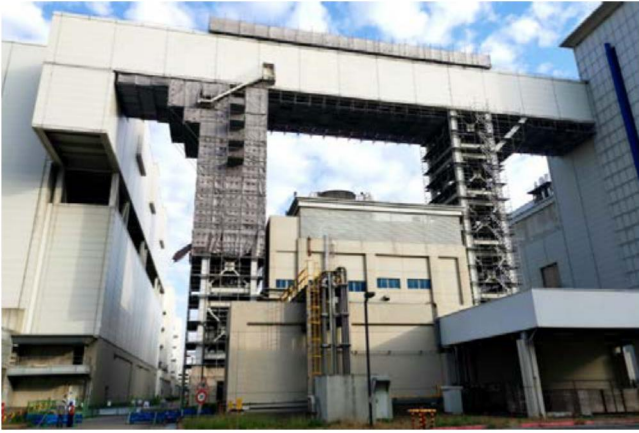
南科群創廠36M高空橋整修懸吊施工架
