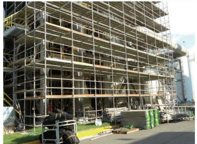
石化業管線歲修用施工架
