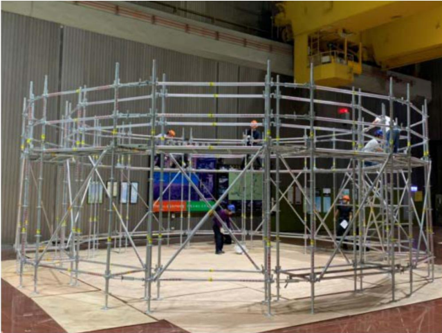
圓桶槽型施工架
