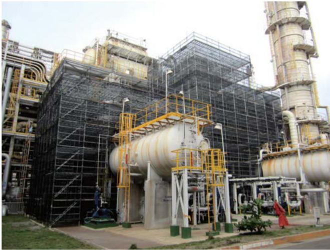
石化設備維修用施工架
