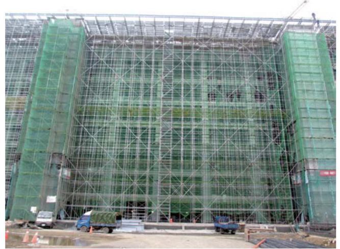
橋頭地方法院屋頂鋼構施工平台架
