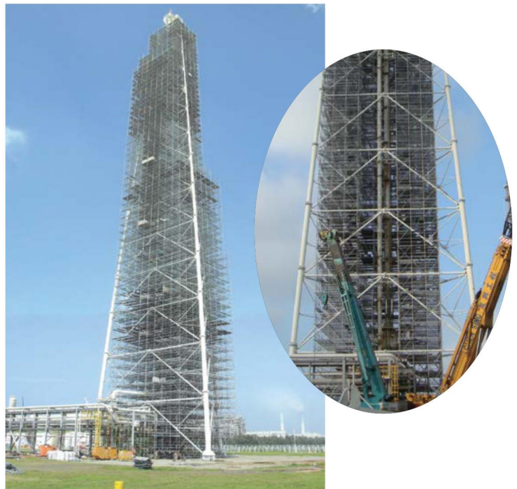
石化業燃燒塔(高度140米)歲修工程
