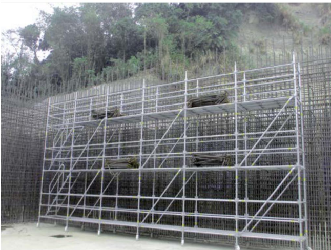
湖山配水池牆筋綁紮用施工架
