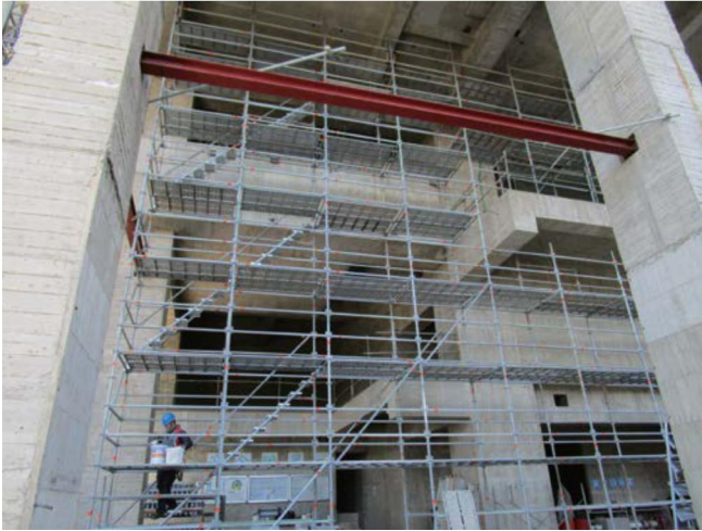
建築大樓外牆修飾用施工架
