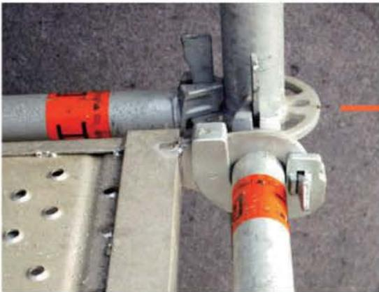
爬梯組裝時，只需將掛鉤確實勾住橫桿即可，掛鉤上的安全設計可使爬梯不脫落並增加固定架體穩定不搖晃，因此不需再使用螺絲、夾具等工具。
