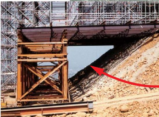
邊坡路段高低落差組架，本支撐架可取代型鋼做挑空組架。
